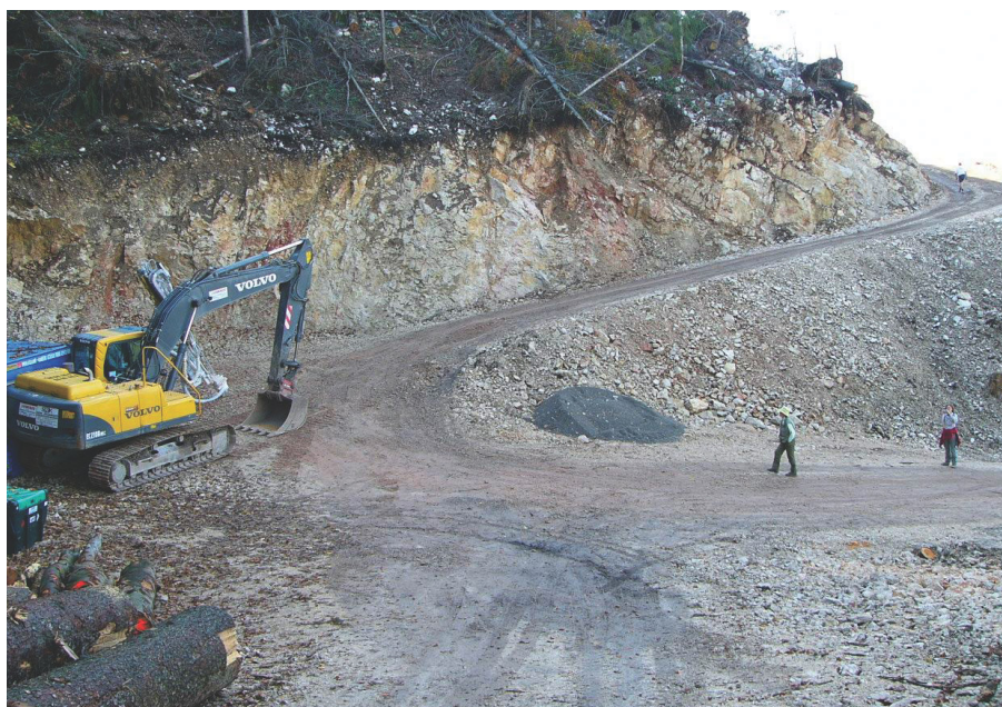
Abb. 8: Forststraßenbau auf der Nordseite des Untersbergs (Österreich). (Foto: Bund Naturschutz, Ortsgruppe Berchtesgaden).
