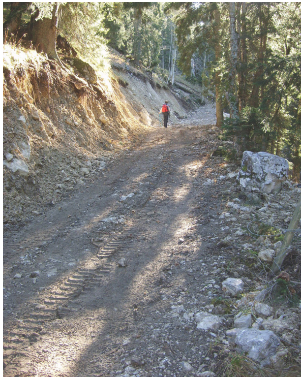
Abb. 3: Almstraßenbau im Naturschutzgebiet Ammergauer Alpen, oberhalb der Kenzenhütte (Foto: M. Schätzl).
