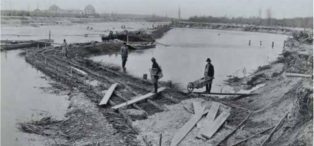
**Abb. 13:** Verbauung des Lechs nördlich von Augsburg bei Langweid mittels Faschinen (Foto um 1898). Im Hintergrund ist das 1907 in Betrieb gegangene Kraftwerk Langweid sichtbar. (© Wasserwirtschaftsamt Donauwörth). (Örtliche und zeitliche Zuordnung der Fotografie nach Stettmayer, F. u. Eberhard, U.).
