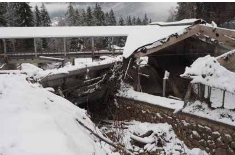
Abb. 1: Der Startbereich der Kunsteisbahn Königssee im Tobel des Klingerbachs. Kurz nach der Katastrophe ist das Wildbachbett weit überfüllt, die Verheerung erinnert an Tsunamis. Verklausung an Querbauten lenkte die Flut in den Eiskanal (oben und Mitte). Unten: Am 30.11.2021 ist der kanalisierte Bach schon teilweise geräumt. (Fotos: oben und Mitte von K. Pfeiffer).
