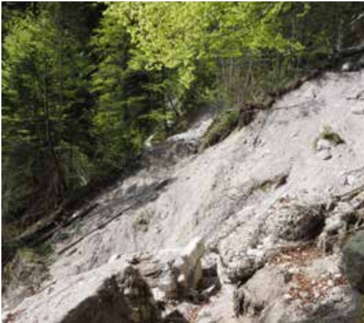
Abb. 9: Die abgehenden Ramsaudolomit-Lockermassen rissen am 17.07.2021 den schwach verankerten Wald samt Bodendecke in die Tiefe, ebenso die Fahrstraße zur Klingeralm, bei deren Bau der äußerst labile Steilhang teils über zwei Meter tief angeschnitten wurde.
