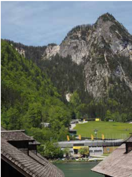
Abb. 18: Grünstein und Kunstseilbahn vom Königssee im Mai 2022; am Beginn des Schwemmkegels der Eingang zum Wildbachtobel, darüber mittig die helle Gleitbahn der Hauptmure vom 17.07.2021. An den Steilhängen lagern vermutlich noch zehntausende Kubikmeter Lockermassen ... und der nächste Starkregen kommt bestimmt! Zudem droht von rechts aus den Dachsteinkalk-Wänden und vom Grünstein ganz erhebliche Felssturzgefahr.
