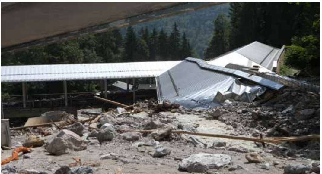
Abb. 1: Der Startbereich der Kunsteisbahn Königssee im Tobel des Klingerbachs. Kurz nach der Katastrophe ist das Wildbachbett weit überfüllt, die Verheerung erinnert an Tsunamis. Verklausung an Querbauten lenkte die Flut in den Eiskanal (oben und Mitte). Unten: Am 30.11.2021 ist der kanalisierte Bach schon teilweise geräumt. (Fotos: oben und Mitte von K. Pfeiffer).
