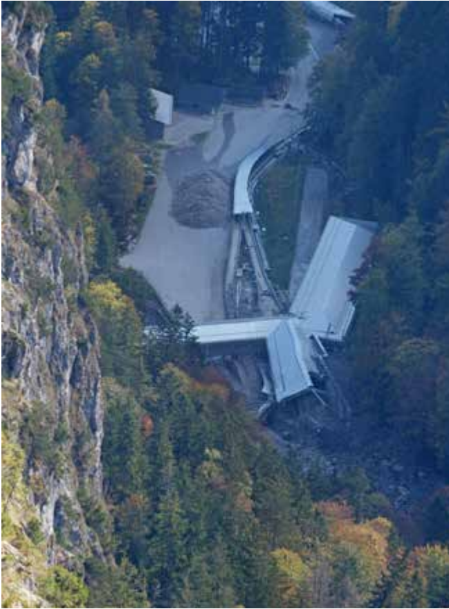
Abb. 16: Im Startbereich der ruinierten Kunsteisbahn wartet Schutt auf Abtransport (Foto vom Weg Grünstein-Kühroint, 18.10.2021). Wären Ortilie und Otto Normalsteuerzahler so dreist, mit eigenem Geld in solch einen Wildbachtobel zu bauen – geschweige denn, dass sie es dürften?
