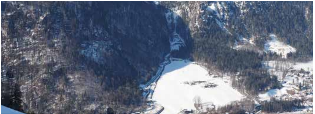
Abb. 12: Der mit Kunsteisbahn und Zusatzbauten vollgestellte Wildbachtobel am 15.02.2022 von den Jennerwiesen. Links im Schatten die Dachsteinkalkwände unmittelbar über der Bahn; im lichten Wald ist das Fallen der Schichten Richtung Bahn zu erkennen. Rechts des Tobels die Ramsaudolomit-Abstürze des Grünsteins.
