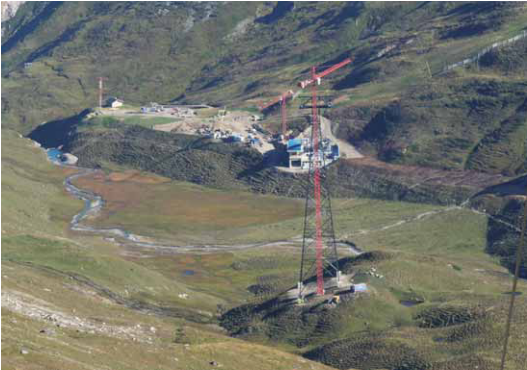
Abb. 3: Schitouristische Bauphase 2013 im Vesital, Talstation der Piz Val Gronda-Seilbahn. Die Dimension der Baumaßnahmen erschließt sich allein schon aus der Höhe von ca. 90 m der Seilbahnstütze im Bereich der Talstation. Foto: © Josef Essl, 7.9.2013.
