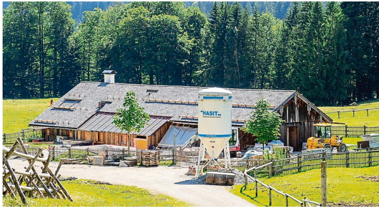
Die Saurüsselalm wird zur Almwirtschaft. Weil jetzt die Baugenehmigung komplett vorliegt, können die Arbeiten zügig voranschreiten. Diese Aufnahme ist im August entstanden.
