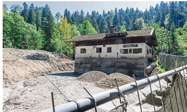
Auch an Haslbergers Söllbachklause laufen die Bauarbeiten.
