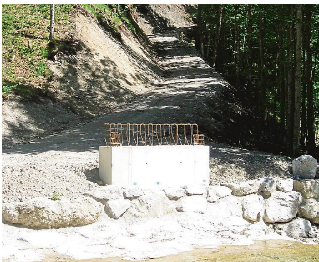
Das Brückenwiderlager und der neue Weg sind am Söllbach nicht zu übersehen. FOTO: PRIVAT
