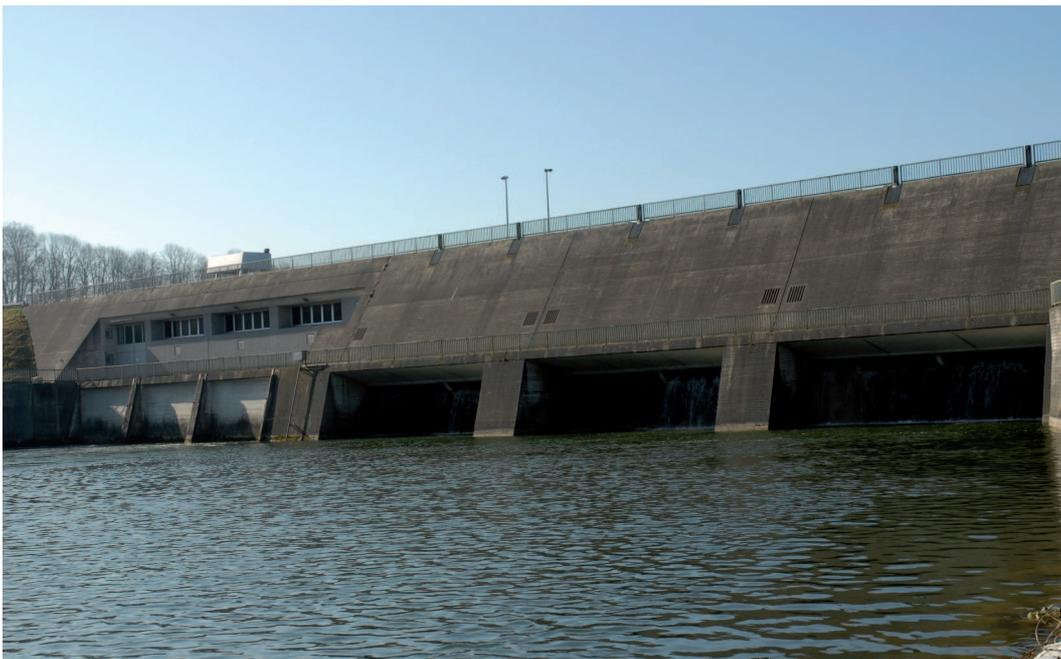
Abb. 19: Hermetisch riegeln allein schon die 24 großen Wehre der Staustufen jede Möglichkeit einer Fischwanderung ab. Stau 19, 6.4.2007. (Foto E. Pfeuffer).
