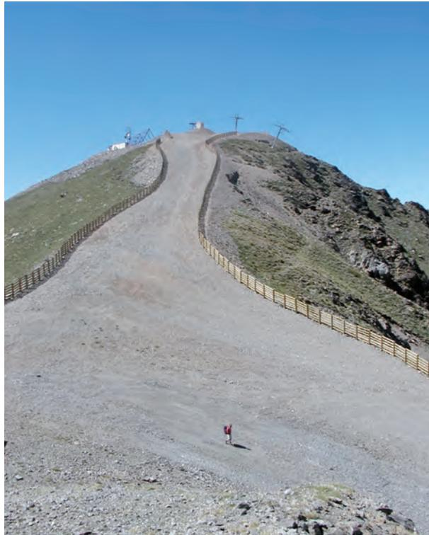
Abb. 13a: Stark erodierte Skipiste im Gipfelbereich der Ski Station Isola in den Hautes Alpes/Frankreich (2400 m Höhe). In Bildmitte befindet sich eine Person als Maßstab. (Foto: Mountain Wilderness).
