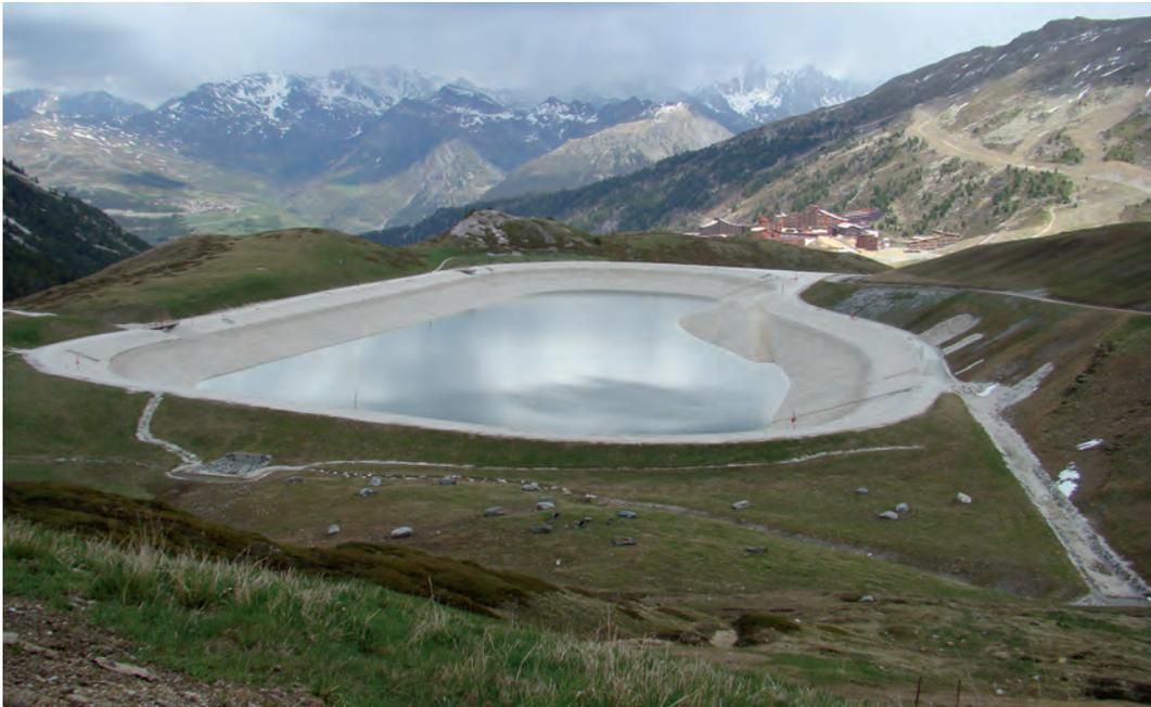
Abb. 6b: Wasserspeicherbecken' Adret les Tuffes (2300 m ü. NN) für die Kunstschneproduktion bei Les Arcs 2000 über Bourg St. Maurice in Savoyen/Frankreich im Monat Mai 2011 während einer langanhaltenden Dürreperiode. Bemerkenswert ist, dass der Speicher mit einem Füllvolumen von 400 000 m<sup>3</sup> auch nach der Schneeschmelze nur zu einem Viertel gefüllt ist (Foto: Carmen de Jong).
